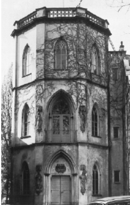
Fig. 2 Schloß Nassau, Neugotischer Turm, zum Andenken an die Napoleonischen Befreiungskriege von Johann Claudius von Lassaulx 1814 errichtet.
