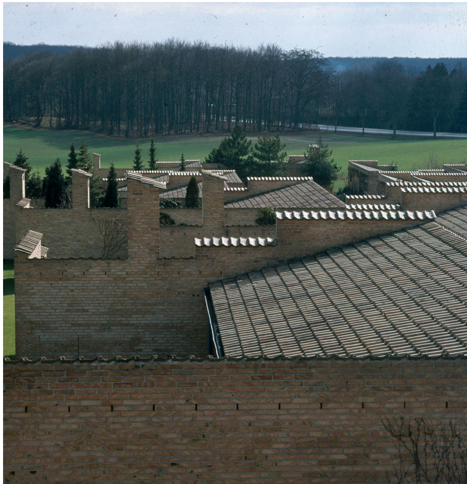
Les Fredensborghusene de Jørn Utzon, 1959-1963 (Fredensborg, Danemark). Photographie de Keld Helmer-Petersen, 1977, Det Kgl. Biblioteks billedsamling.
