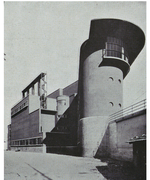
La centrale thermique et la cabine de la gare de Florence, Angiolo Mazzoni architecte, L'Architecte d'aujourd'hui , n°8, août 1936, p. 47
