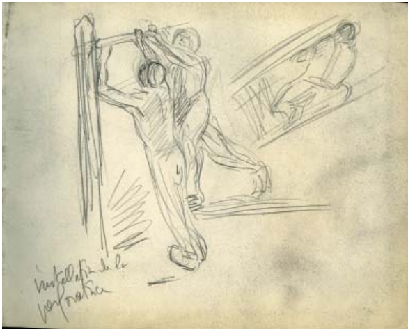
Dessin 9 : [Denain : installation de la perforatrice]
